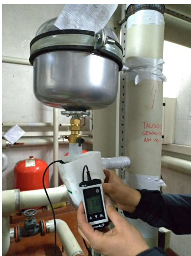
Fig. 3 - sottostazione 2C: rilevazione temperatura mandata acqua calda sanitaria
